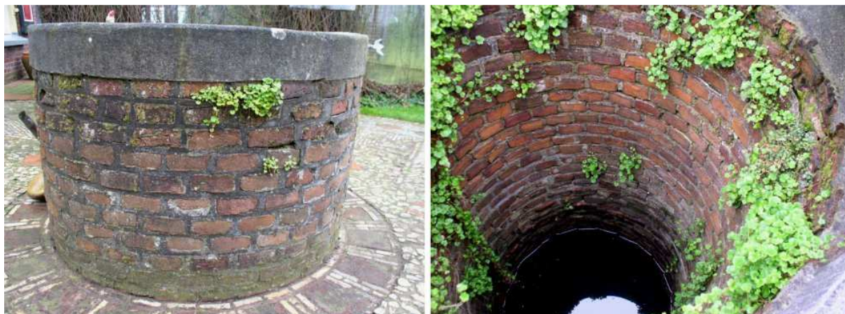
Een Winterswijkse bakstenen waterput. De bovenrand is aangesmeerd zodat het lijkt op (kostbaar) Bentheimer zandsteen. In en op de put groeien Muurleeuwenbek en Muurvaren. Beerninkweg 24 maart 2007
