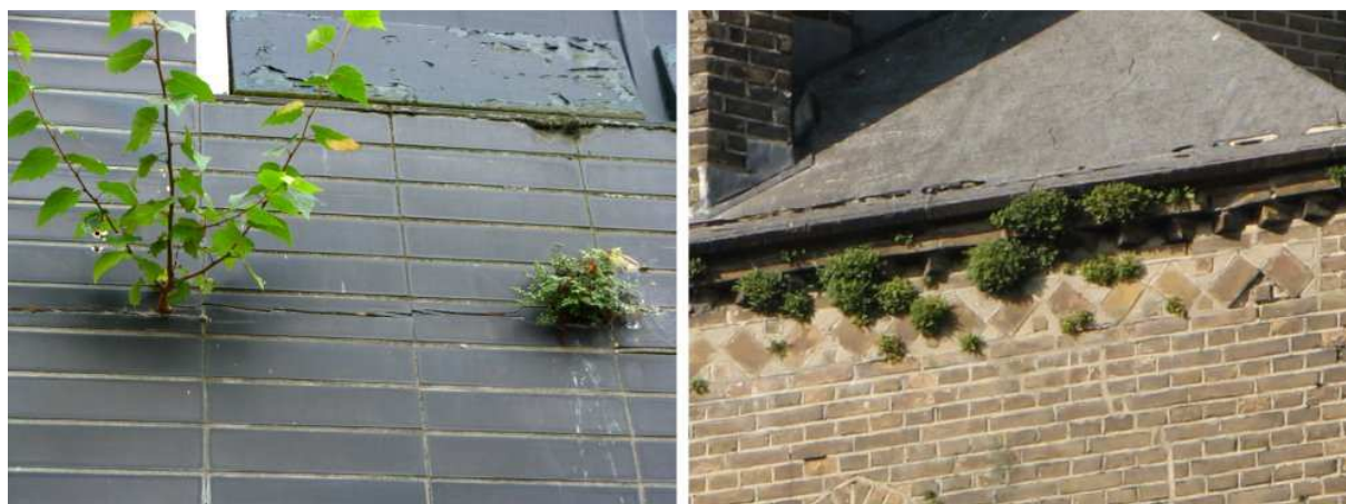
(L) Muurvaren en een ruwe berk tussen geglazuurde stenen op een leegstaande winkel in Winterswijk op 2 september 2008 en Muurvaren hoog op de muur van de kerk in Lichtenvoorde op 29 augustus 2007. De kerk is inmiddels gerestaureerd, de varens zijn nu verdwenen (R)
