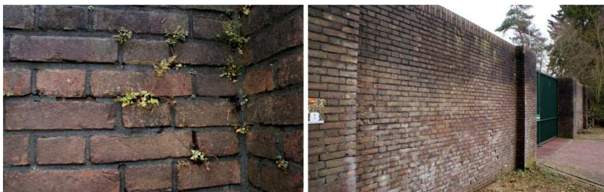
Zwartsteel en Muurvaren aan de zuidkant van de muur van een begraafplaats in Dieren op 24 februari 2010
